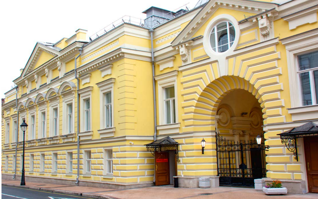
► Главный фасад «Геликон-оперы» со стороны ул. Б. Никитская
